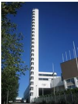
Sisäänkäynti tornin juurelta
